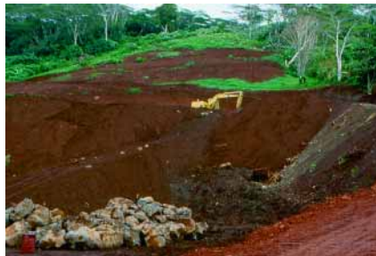
Travaux de terrassements.
