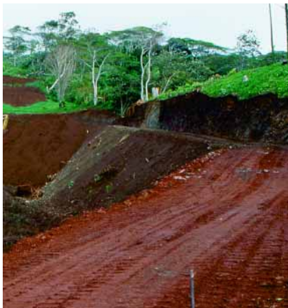
Percement de route dans les pentes.
