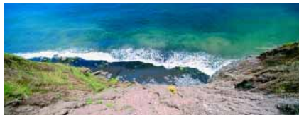
Eboulement de terre dans le lagon.
