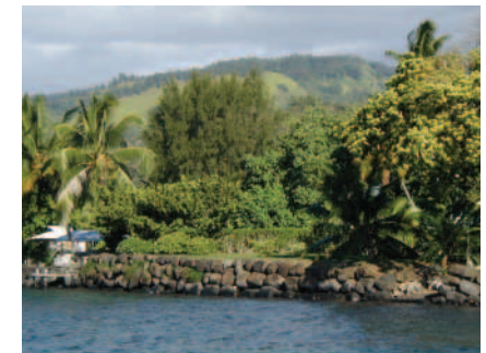
Remblais et enrochements.
